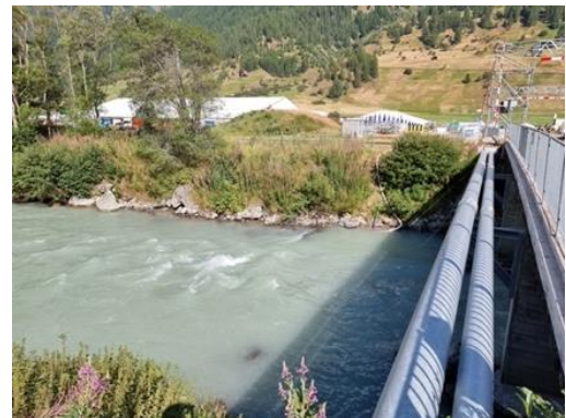
Foto 40: Für die Kühlung wurde auch Rottenwasser genutzt (Matthias Schlegel / Twister)
