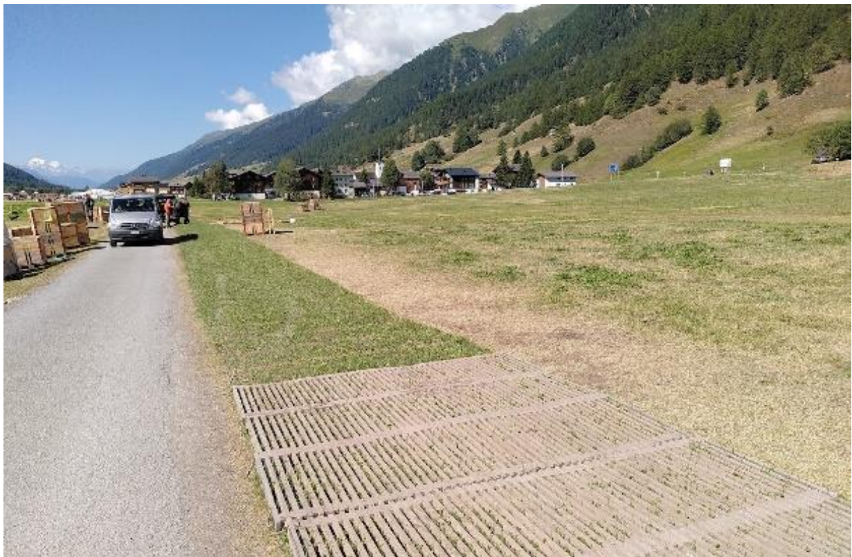
Foto 21: Die Bodenschutzelemente haben den Boden geschützt. Beim Abbau zeigte sich die unbeschädigte Wiese. (Mischa Kaspar / Monti)
